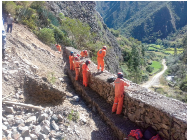
道路整備のため落石防止壁を設置しました(ジャマック村近郊にて)
